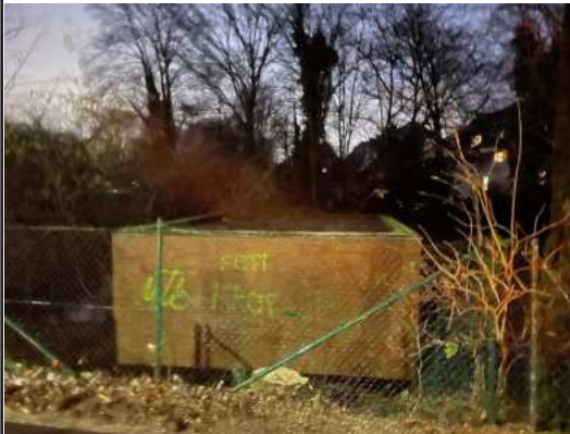
Sanierung des Trafohäuschens
